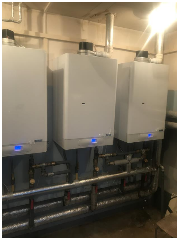
Obrázek 6. Poslušného 7 – 3 nové kotle vč. rozvodů
