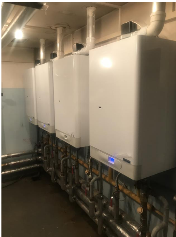
Obrázek 8. Poslušného 9 - Nové 4 kotle vč. rozvodů
