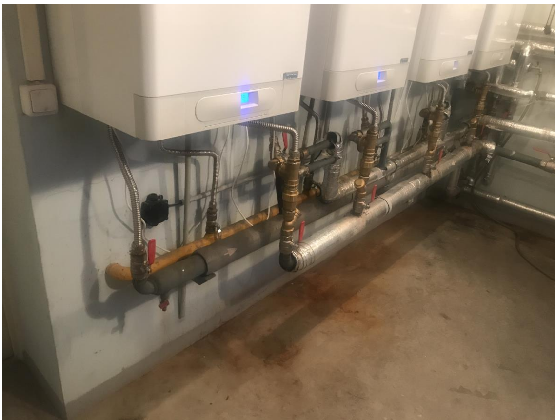
Obrázek 2. Poslušného 5 – nové přívody plynu a napojení na stávající rozvody, nové zpětné ventily
