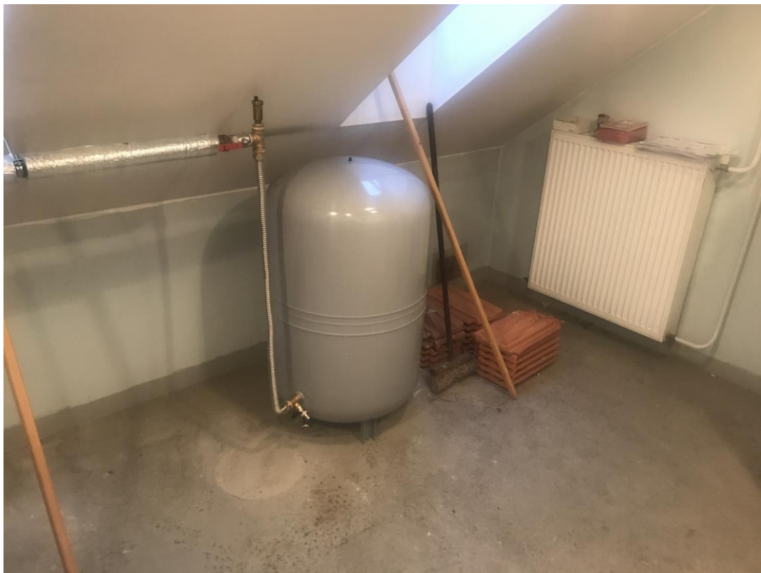
Obrázek 4. Poslušného 5 - Nová expanzní tlaková nádoba
